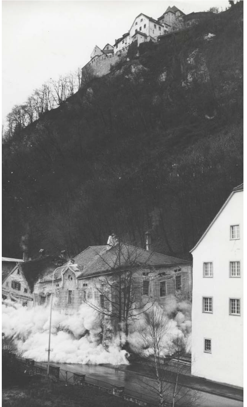
Alte Realschule Ständehaus Sprengung, Vaduz
