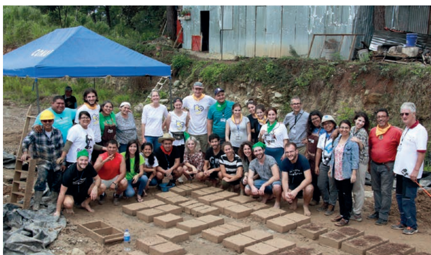
Neue Erfahrungen mit Adobe-Lehmziegeln in El Salvador.
