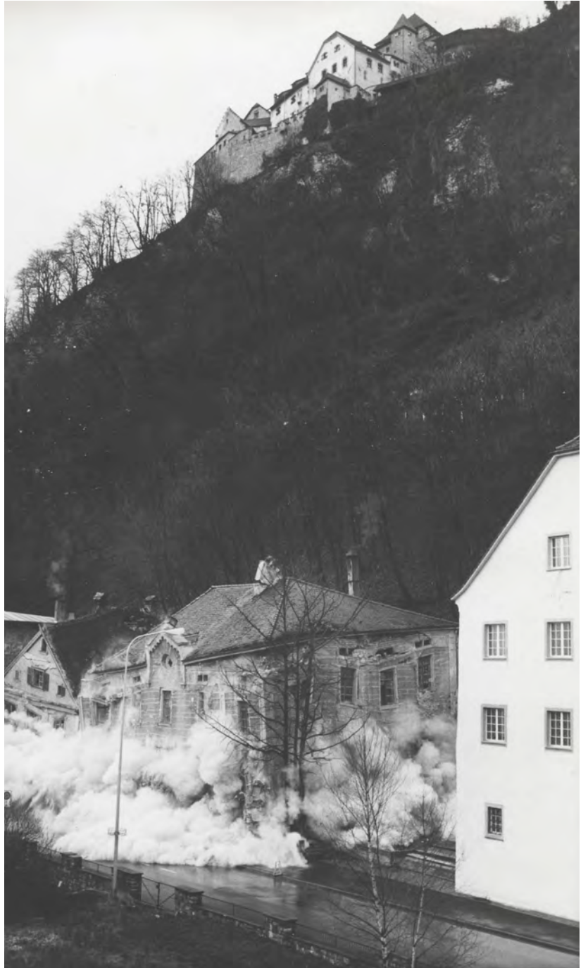
Alte Realschule Ständehaus Sprengung, Vaduz
